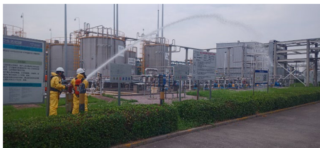
消防喷淋启动
